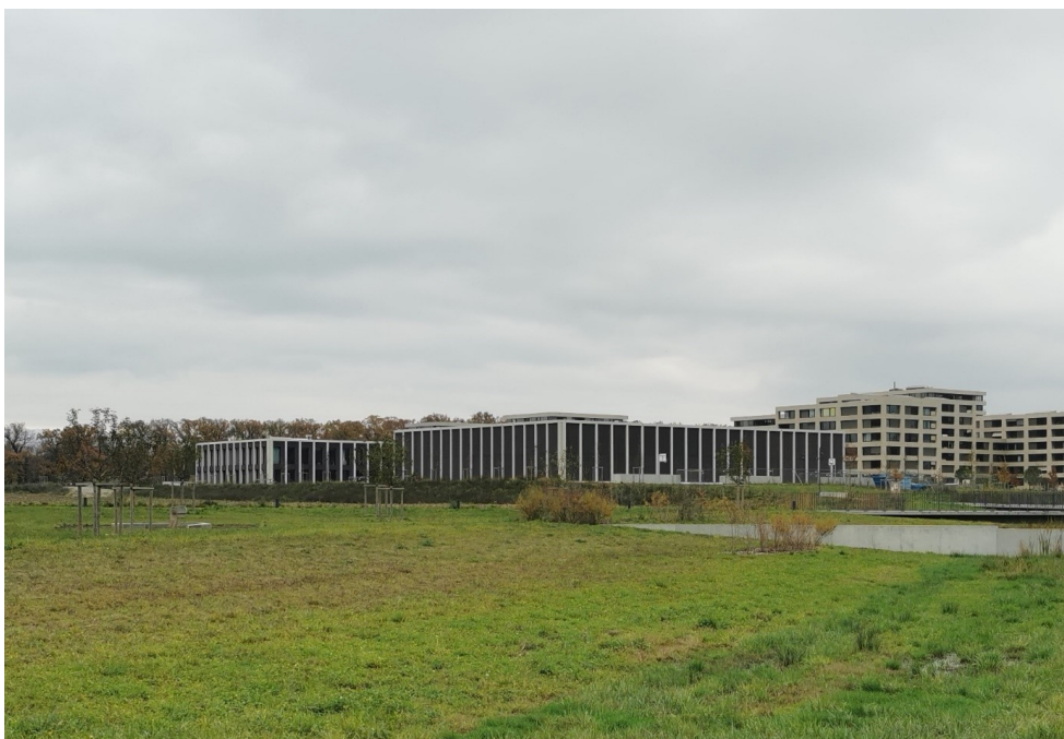
Photo école Belle-Terre vue nord depuis les espaces publics (diagonale)
