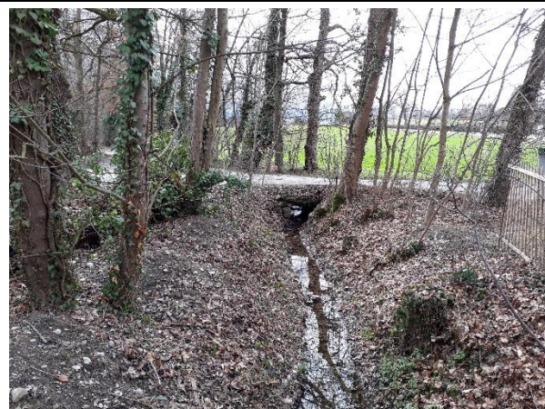
4. Tronçon 3 - Traversée de la route de Moillebin (12.03.2018)
