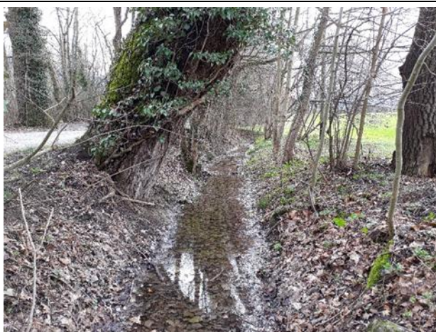
5. Tronçon 2 - Amont de la route de Moillebin (12.03.2018)
