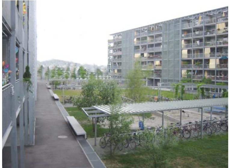
Espace entre bâtiments: quartier d'habitation Regina-Kägi-Hof, Zürich (Théo Hotz arch., 1999-2001)
