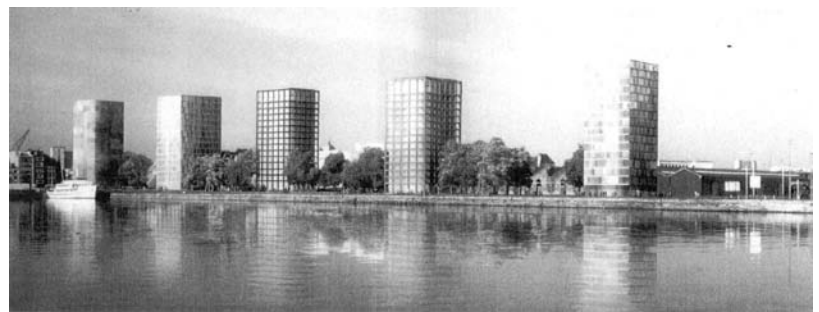
Des édifices se signalant à l'échelle du territoire et bénéficiant de vues sur le grand paysage: De Branding Appartement, Amsterdam-Nord, Pays-Bas (Gert-Jan Hendriks arch., 1995)
