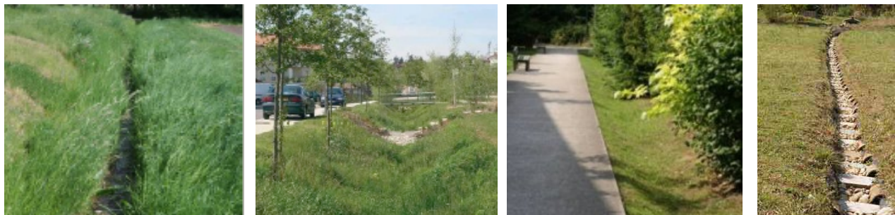
Noues d'infiltration
