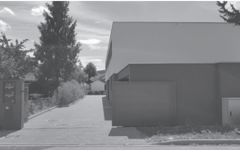
Façade aveugle, garage en limite de propriété, absence de végétation, création d'une nouvelle desserte privée
