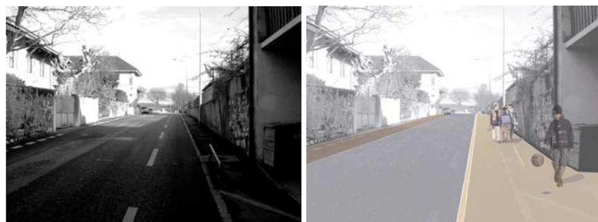
Route du Mandement en traversée du village : élargissement du trottoir et diminution de l'emprise visuelle de la chaussée (illustration d'un principe d'aménagement).
