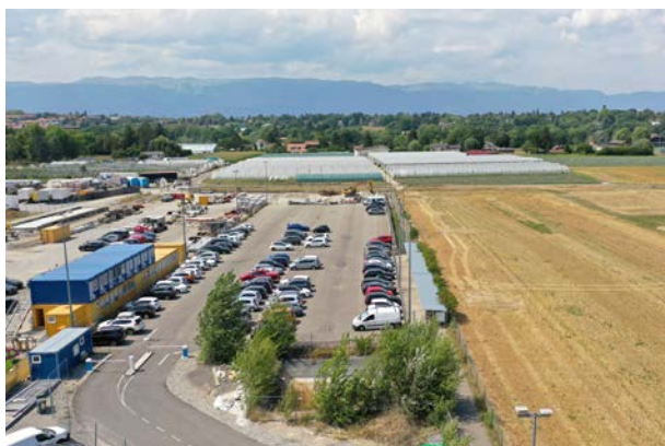
Les Cherpines - vue nord - situation en août 2022
