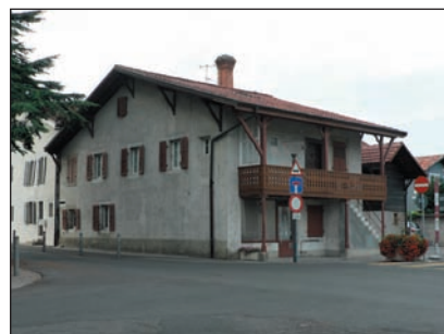
Angle nord ch. du Bournoud, - av. Malnati
