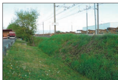
Talus CFF - Zone industrielle
