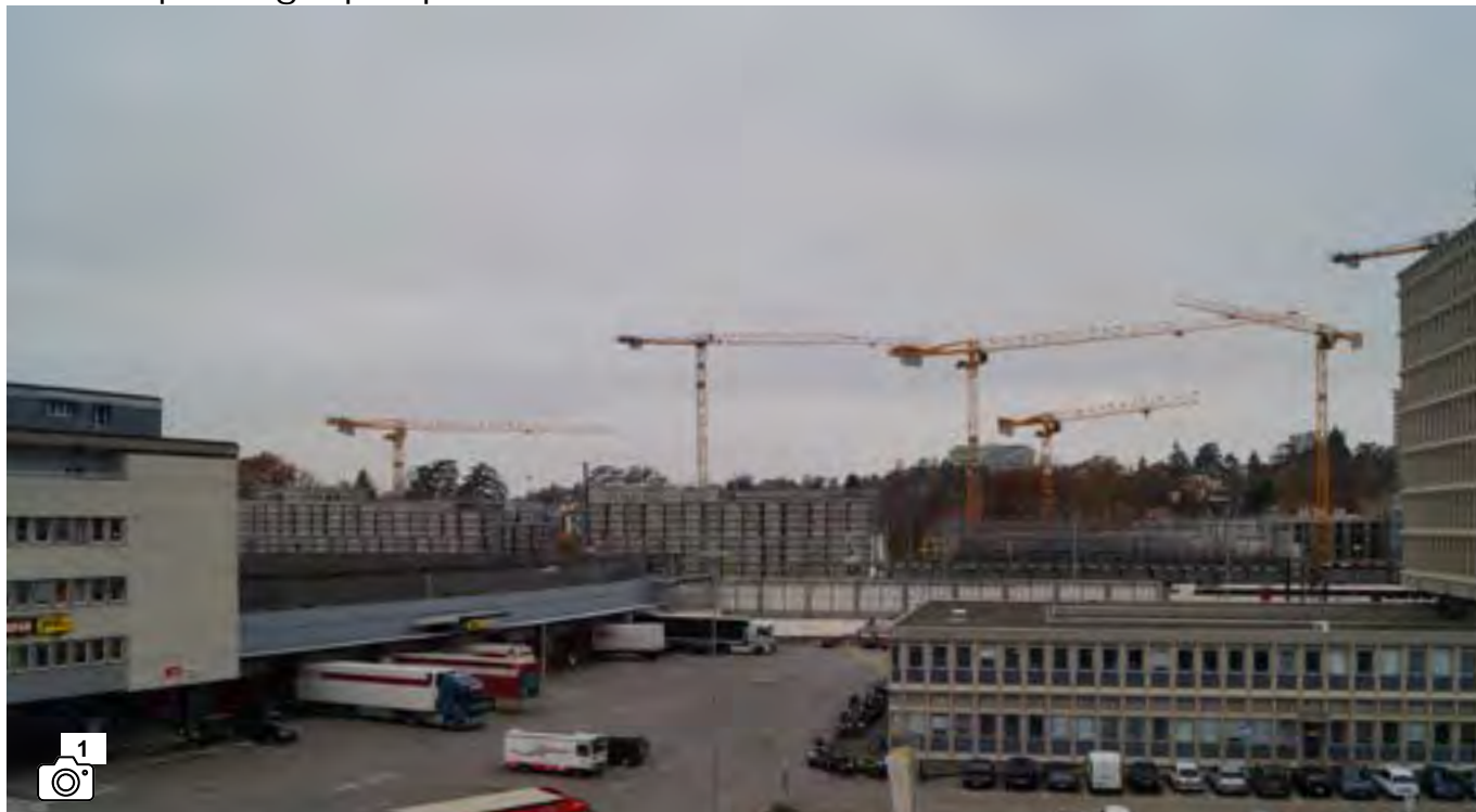
Vue depuis la route des Jeunes sur le nouveau quartier de Pont Rouge.
