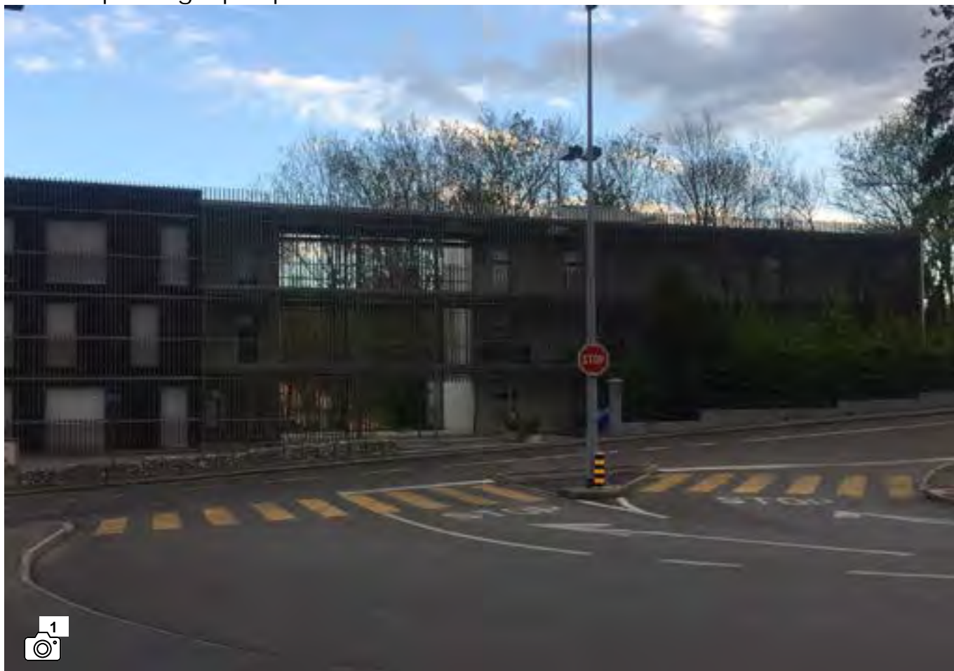
Vue sur la zone de conflit, positionnement dangereux de la ligne de stop.
