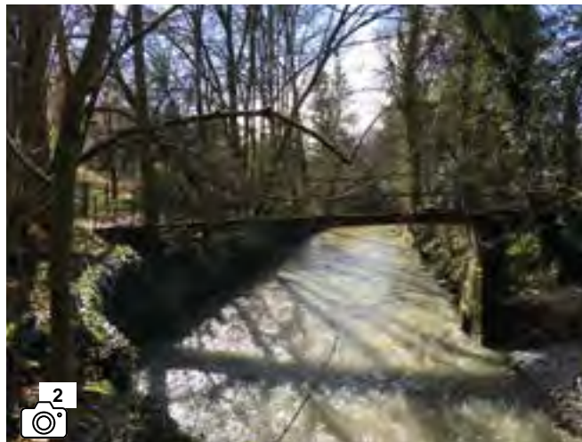
Vue de la passerelle existante.
