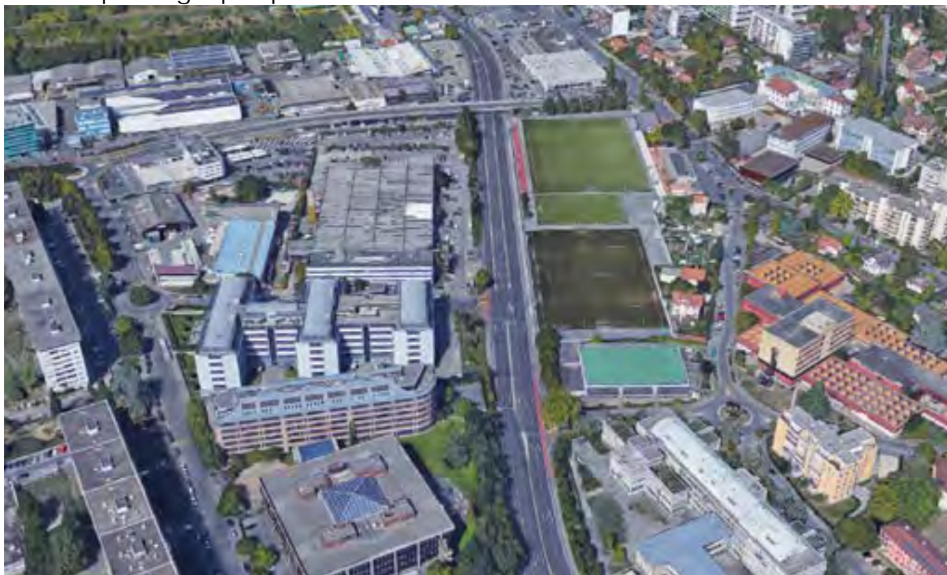
Vue aérienne google de la route du Pont Butin aux abords du stade de Florimont
