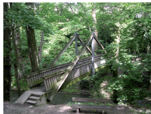
pont sur l'Aire
