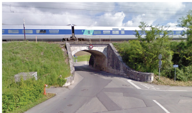
Le pont ferroviaire vu du sud (source : google street view)
