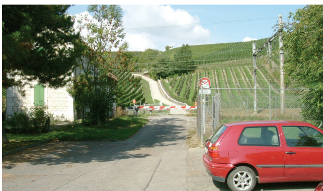
Passage à niveau sur la route de la Donzelle
