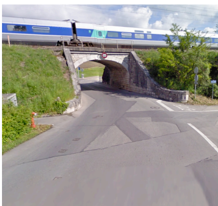
Route de La Plaine : pont ferroviaire avec gabarit limité à 3.40 m
