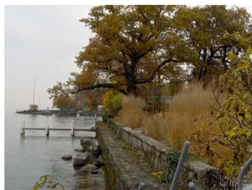
Rive artificielle et parc arboré
