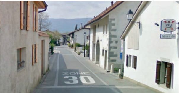
Exemple de réaménagement de chaussée dans une zone 30 (route de Valleiry à Chancy)
