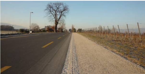
Exemple d'aménagement d'un cheminement piéton en marge de la chaussée (route de Chevrens à Anières)
