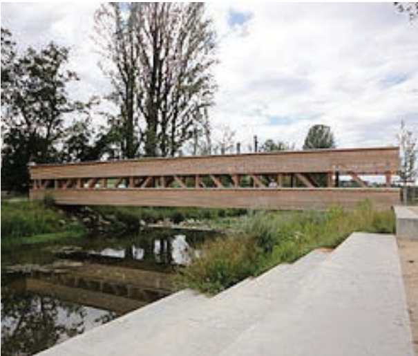
Exemple de réalisation d'une passerelle piétonne au-dessus d'une rivière renaturée (Passerelle piétonne des Bis franchissant l'Aire entre Certoux et Lully)
