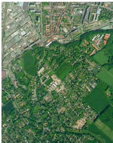
Figure 70: Vue aérienne de Carouge Sud au début des années 2000 (Source: SITG/extrait du document de la Stratégie d'aménagement « Carouge Sud » (image directrice), 2015)
