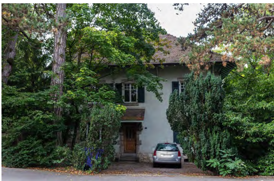
Figure 86: Carouge 2021, bâtiment faisant partie de l'ensemble de villas à Grange-Collomb identifié par l'ISOS (Source: ISOS, ©BAK Bern)
