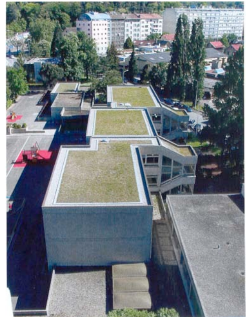
Toiture végétalisée sur l'école des Promenades
