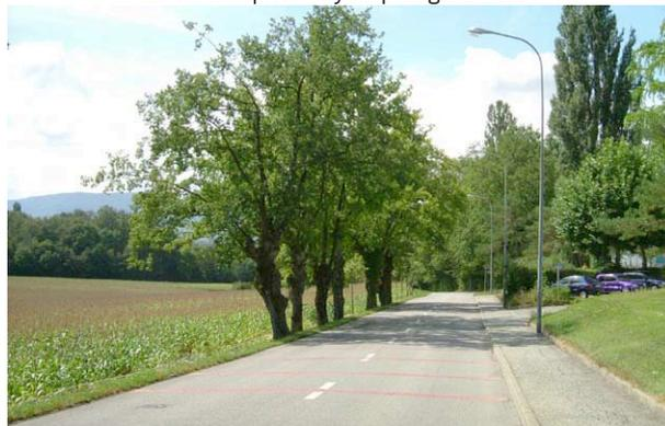
**Figure 79:** Coupe de principe : aménagement chemin piéton-cycle entre Epeisses et Gennecy. Le léger rétrécissement de la route modère le trafic en cas de croisement de véhicules. Le cheminement est en légère surélévation pour marquer son emprise, mais n'empêche pas à un véhicule de rouler partiellement dessus en cas de croisement d'un autre véhicule hors gabarit (bus).
