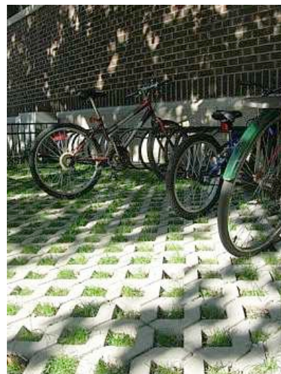
Stationnement avec revêtement perméable, Montréal (QC).
