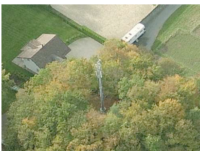
Antenne de téléphonie mobile, Vandœuvres.
