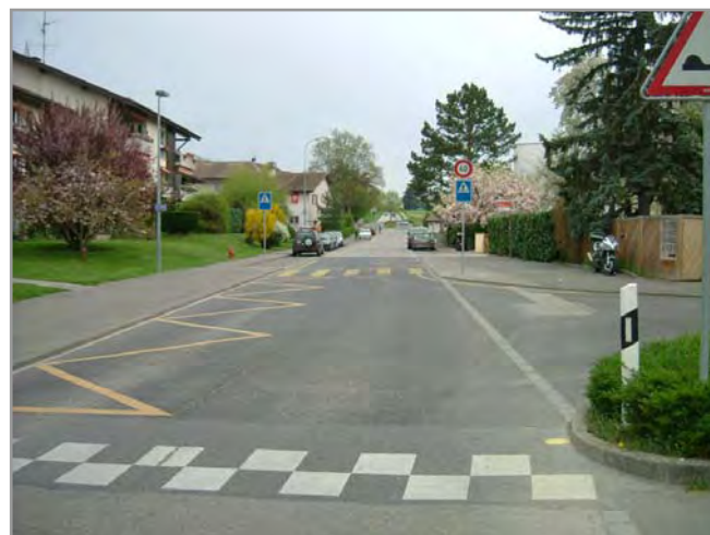
Route de Saconnex-d'Arve (carrefour avec le ch. des Contamines)
