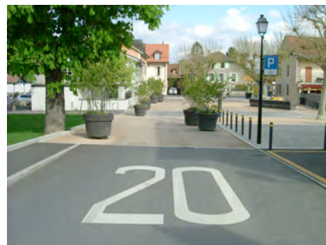
Zone de rencontre place des Bourneaux (mairie)
