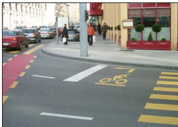
Le tourner-à-gauche indirect est à réaliser le moins en retrait possible de l'axe routier à traverser, de préférence en avant du passage piéton de l'axe perpendiculaire. Il devrait en outre rester une option et
