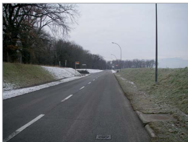
Route de Valavran (tronçon A)
