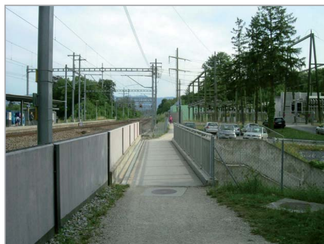
Passerelle au-dessus de la route des Romelles
