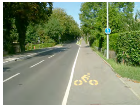
Trottoir mixte le long de la route de Collex
