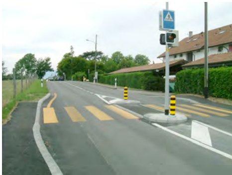
Traversée sécurisée (route des Fayards)
