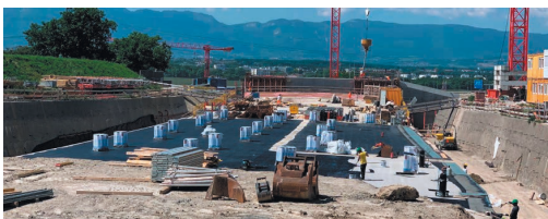
Travaux de liaison entre la route des Nations et la jonction autoroutière
