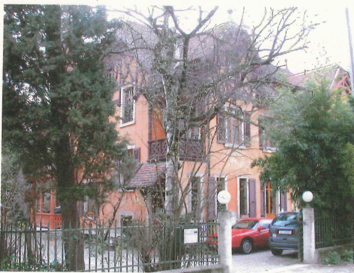
N° 21 C av. de Miremont, vue depuis le nord-est
