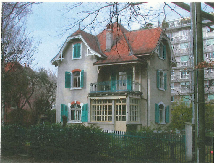
N° 23 C av. de Miremont, vue depuis le sud
