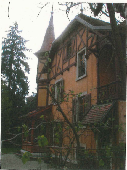
N° 21 C av. de Miremont, vue depuis le nord-est
