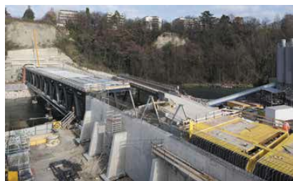
VAL D'ARVE – Le pont sur l'Arve, entièrement bétonné, est en train d'être relié au tunnel de Pinchat (coin inférieur droit de l'image) ainsi qu'au tunnel de Champel (coin supérieur gauche).
