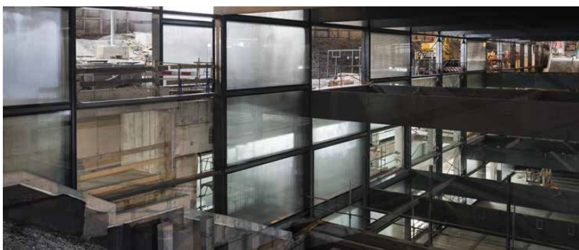
CHAMPEL-HÔPITAL – La pose des briques de verre se poursuit dans l'émergence de la halle de Champel-Hôpital
