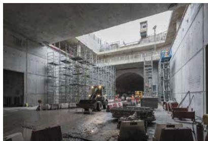
CAROUGE-BACHET – la trémie située à l'extrémité de la station côté TPG – on aperçoit l'entrée du tunnel de Pinchat – est en train d'être partiellement couverte. C'est ici que se dressera l'émergence en briques de verre.
