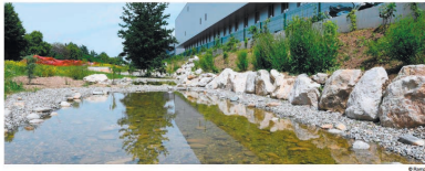
Des solutions existent: La noue pluviale de Meyrin attire des libellules dans la zone industrielle
