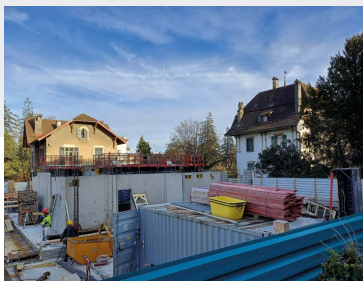
Chemin Daniel-Ihly 3 : Chantier Société coopérative d'habitation Les Marbriers
