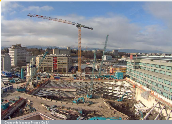
Chantier de la banque Pictet &amp; Cie SA
