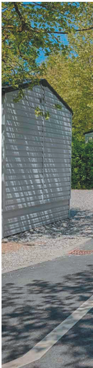
Centre d'hébergement collectif du Bois-de-Bay
