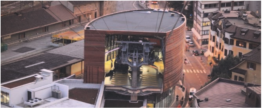
Figure 5 : Gare aval de la télécabine 3S de Bolzano (I).
