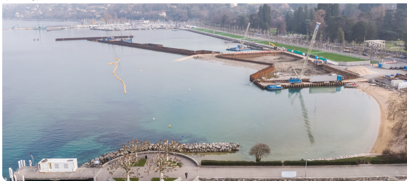
LE CHANTIER DE LA PLAGE PUBLIQUE DES EAUX-VIVES - Vue du ciel
