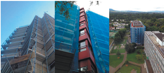
Photos : travaux façade bâtiment C, chantier
