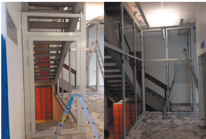
Photos : sécurisation des contrôles d'accès du bâtiment B, chantier
