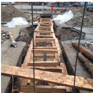
Photos : tranchée pour le remplacement complet de la conduite et nouveau revêtement bitumineux après travaux
