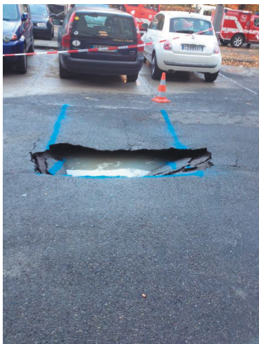
Photos : dommages au revêtement bitumineux du parking devant le bâtiment B et réparation provisoire de la conduite d'alimentation
