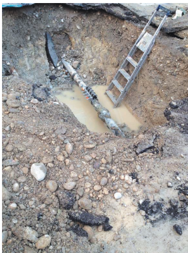
Photos : dommages au revêtement bitumineux du parking devant le bâtiment B et réparation provisoire de la conduite d'alimentation
