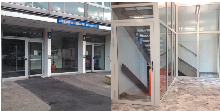
Photos : sécurisation des contrôles d'accès du bâtiment B, réalisations
