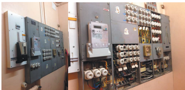
Photos : rénovation du tableau électrique de l'épicerie, chantier
