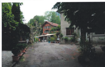
2. Vue du bâtiment à démolir
