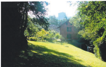
4. Vue du bâtiment à démolir
