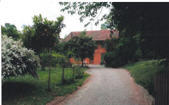
3. Vue du bâtiment à démolir
