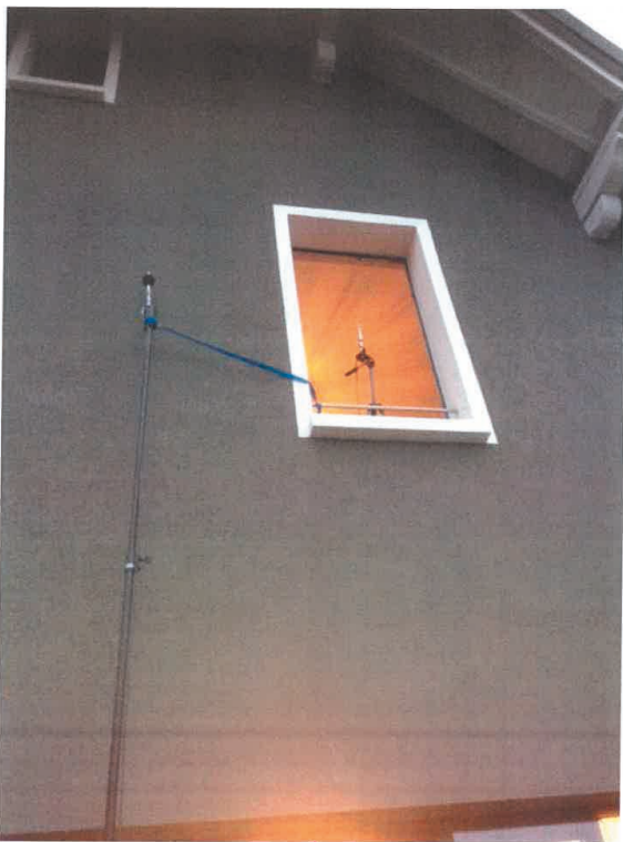
Figure 7 : Photographie de l'installation des sonomètres lors de la mesure
