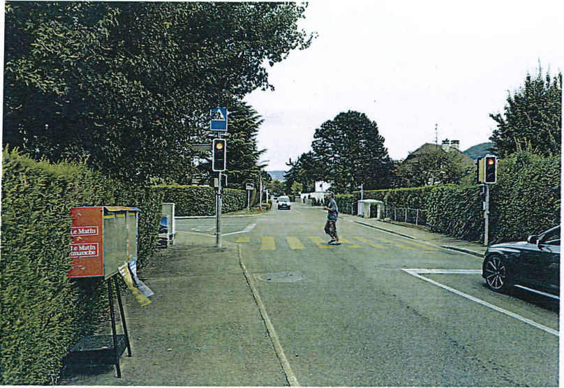
Photo 7 : Carrefour aménagé : feux à bouton poussoir pour piétons
