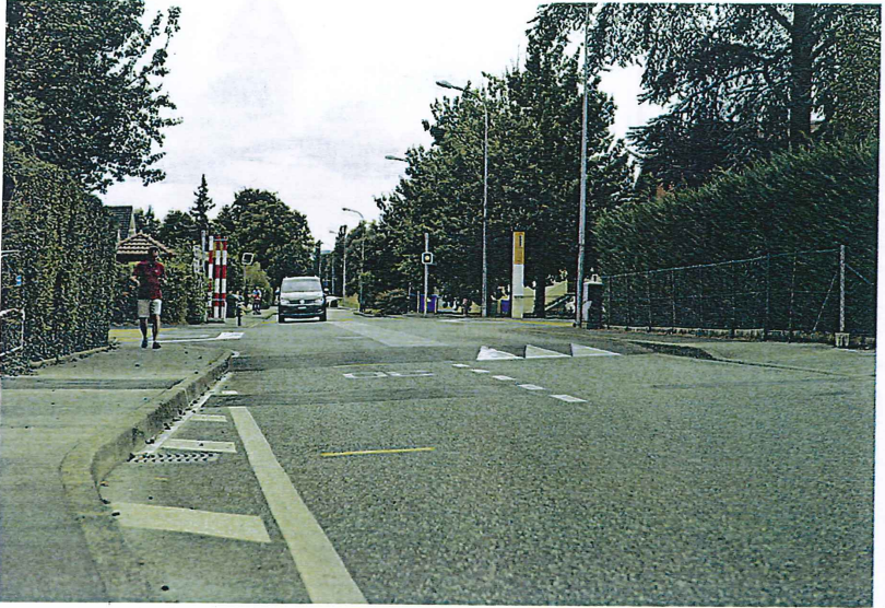
Photo 15 : Carrefour de la poste, surélevé et dégagé
