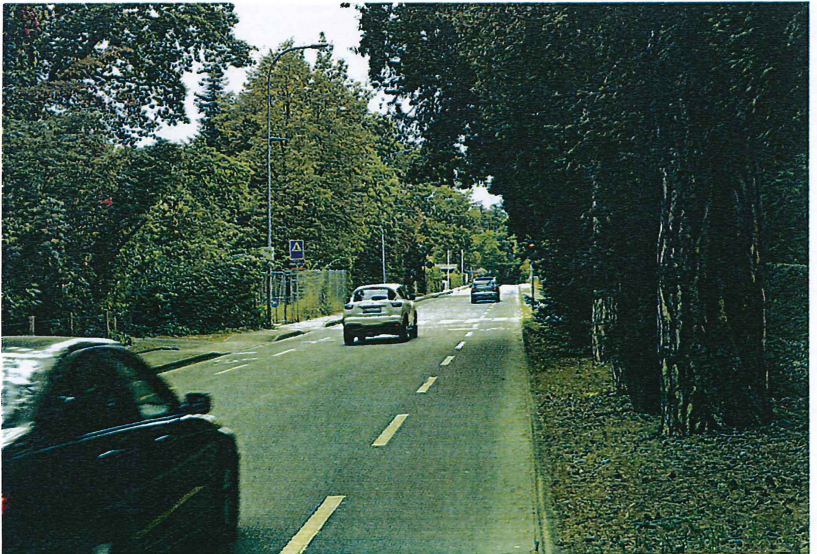
Photo 12 : Passage sans protection (sauf feu orange clignotant, dans l'arbre...)
