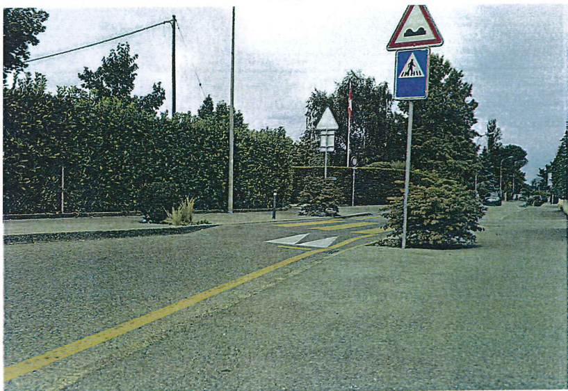
Photo 13 : voirie rétrécie, surélévation, passage piéton sécurisé
