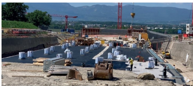
Chantier en juin 2020
