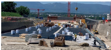
Chantier en juin 2020
