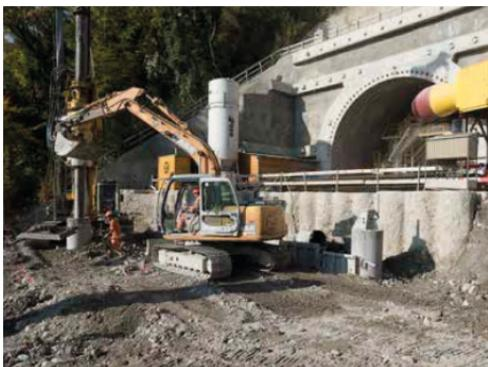
**VAL D'ARVE** - Réalisation des pieux en vue de la construction de la culée (appui définitif) rive droite du pont sur l'Arve
