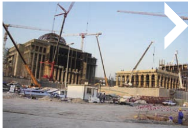
Chantier de la Princess Noura Bint Abdulrahman University
