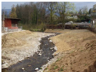
Situation fin de chantier 2005
