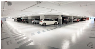
Après les travaux
