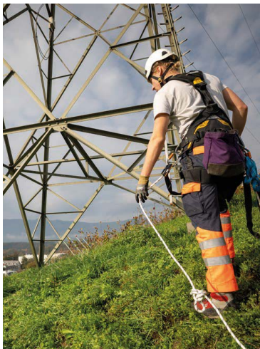
Réseau électrique aérien
