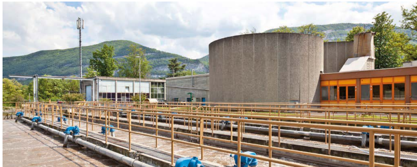
Station d'épuration de Vilette
