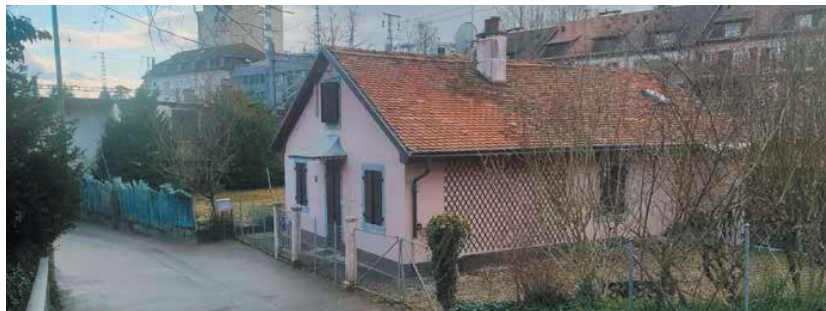
Chemin du Val-de-Travers, Versoix
