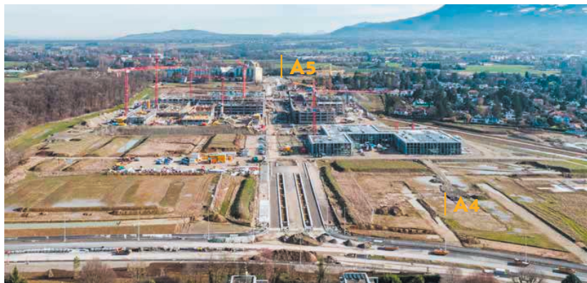
Chantier des Communaux d'Ambilly
