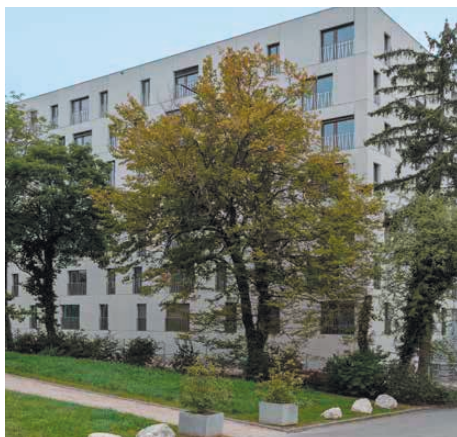
Chemin Daniel-Ihly, Lancy | Bureau CLR Architectes SA
