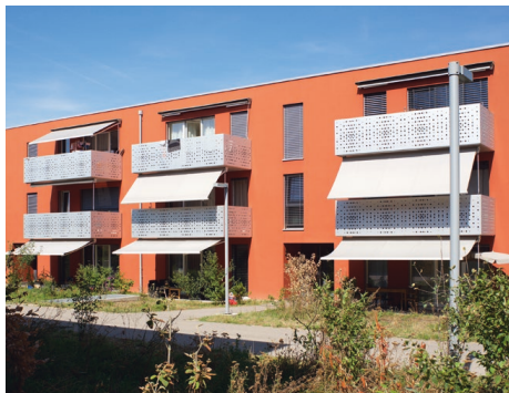
Rue Joseph-Berthet 5 et 7, Confignon Fondation d'intérêt public communal pour le logement à Confignon
