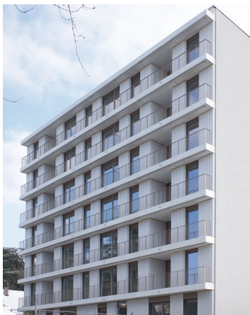
Avenue de Riant-Parc 3, Petit-Saconnex Les Ailes société coopérative
