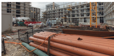
Chantier de l'Adret Pont-Rouge
