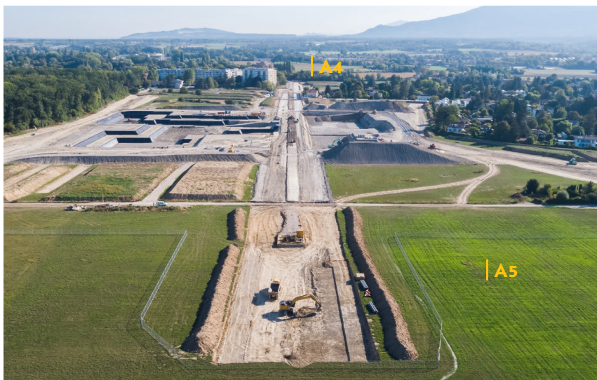
Travaux préparatoires du chantier des Communaux d'Ambilly
