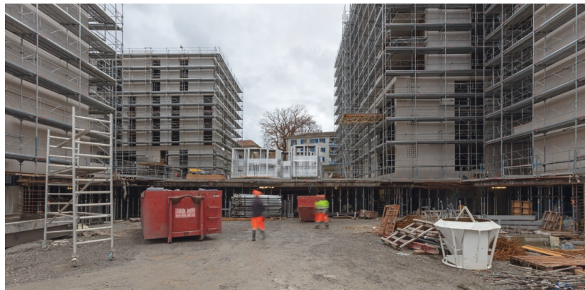
Chantier de l'Adret Pont-Rouge
