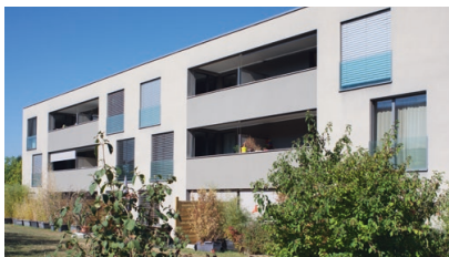
Route de Loëx 83-85, Confignon Société coopérative d'habitation Cooplog-Loëx
