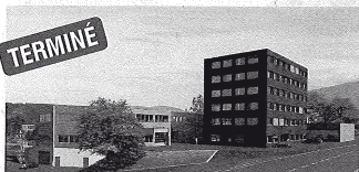
TERMINÉ BBC Bois de Bay Center Bâtiment env. 8'000 m 2
