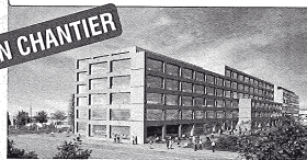
Skylab Centre multifonctionnel de 29'000 m 2
