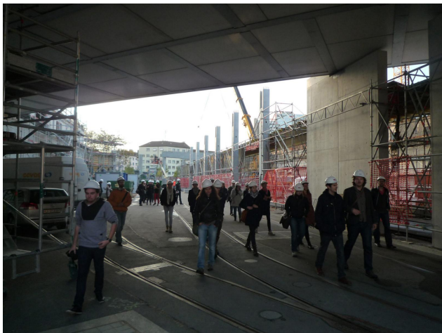
Avant la construction de la dalle
