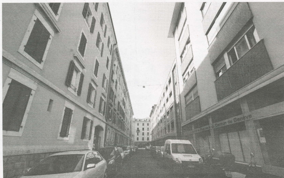
Récents ou anciens, tous les immeubles doivent être assainis.
