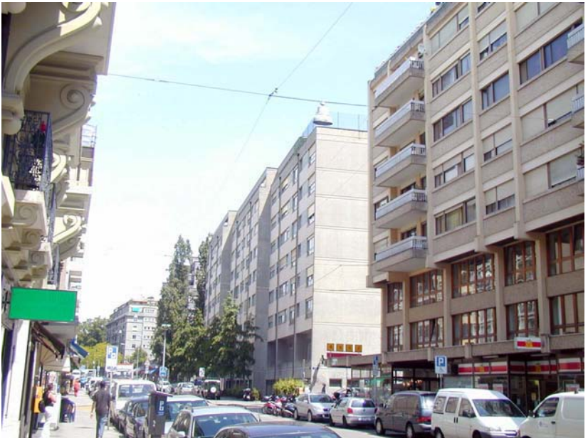
rue de Montchoisy demain (+1 étage)
