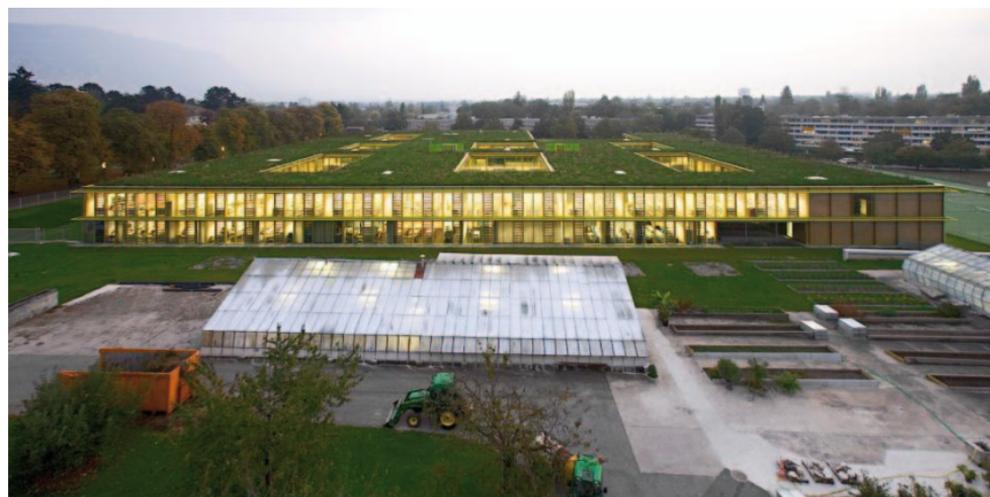
La toiture recouverte d'une prairie restitue celle perdue par la construction et permet une insertion douce dans le paysage. Grâce à sa faible hauteur, qui reprend l'échelle des constructions voisines et de la ferme, elle contribue favorablement à la préservation de l'espace naturel avec la diversité des espèces présentes sur le site.
